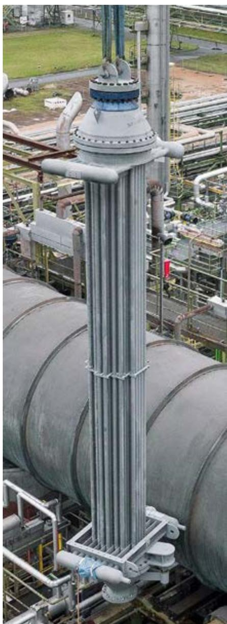
Einbau eines Wärmetauschers in eine petrochemische Anlage (alle Bilder © SCHMIDTSCHESCHACK | ARVOS GmbH)
