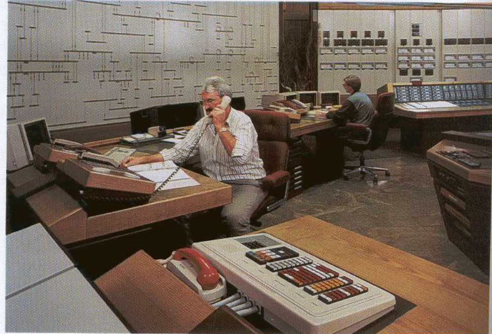
Dispatching Laufenburg. (Bild 100)
