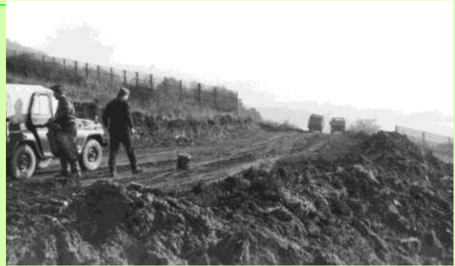
Ehemalige Straße zwischen Trefffurt und Wanfried wird provisorisch hergerichtet
