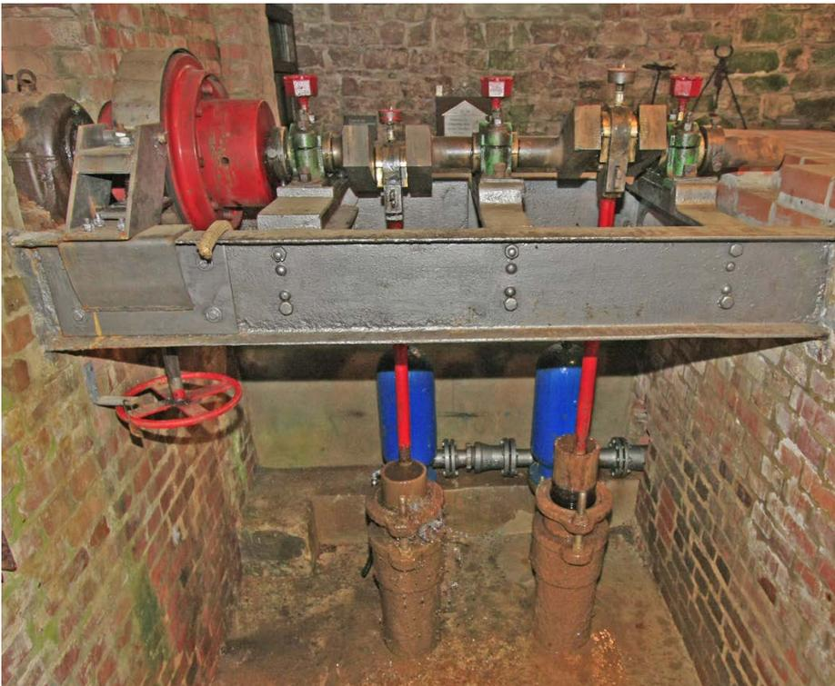
Kurbelwelle und Kolbenpumpen mit dahinter angeordneten Windkesseln der Wasserkunst Landau
